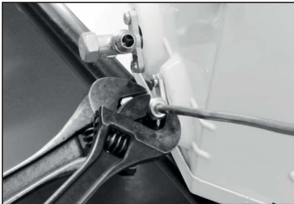
FIG. 37 - FIXAÇÃO DA PORCA
